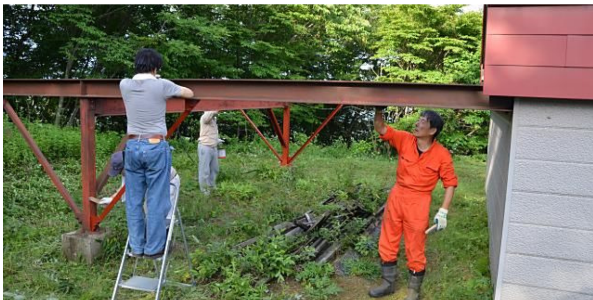
観測室の塗装作業
